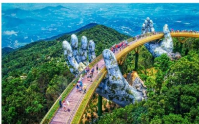
สะพานลอยฟ้า Golden Bridge
