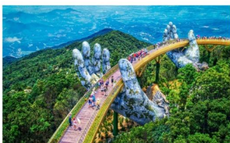
สะพานลอยฟ้า Golden Bridge
