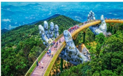
สะพานลอยฟ้า Golden Bridge
